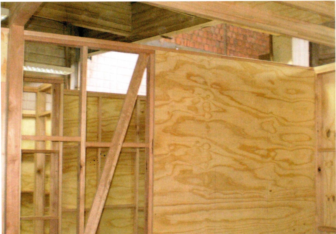
Prototipo de las viviendas que se construirán en Rivera.
